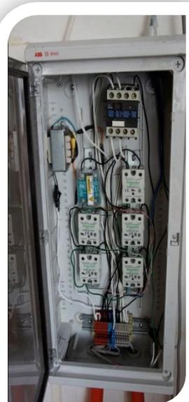
El control del riego se integra por hardware (sensor de humedad del medio poroso FDR) y software, que permite el riego ó no, al accionar (encender/apagar) bomba de agua en forma automática
