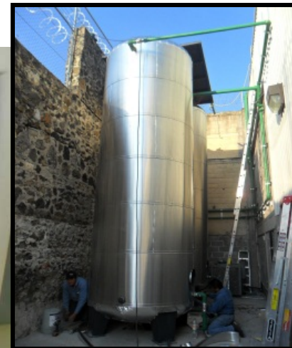
Termotanque de 15,000 litros sistema solar
