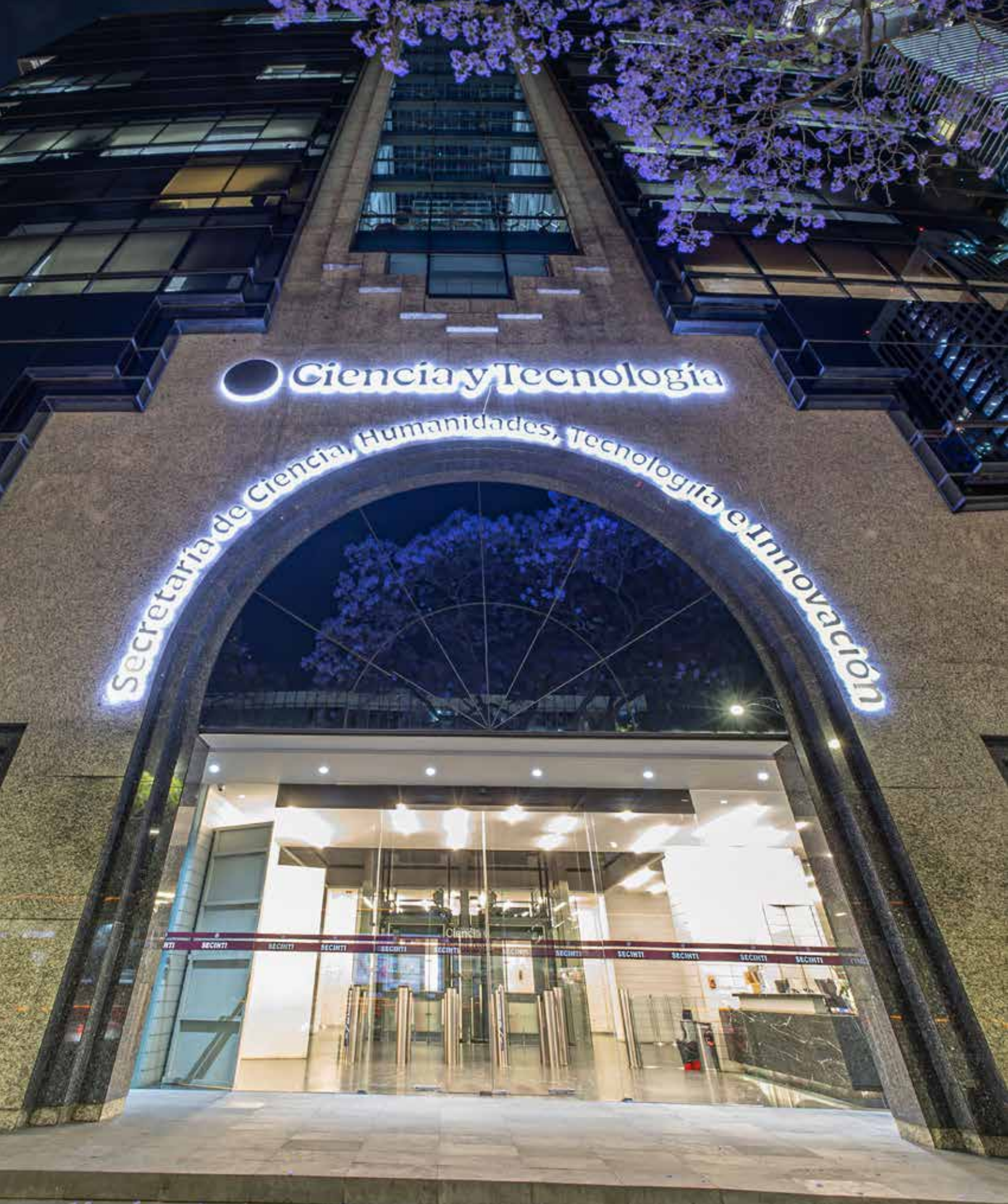
Foto de la fachada iluminada del edificio sede de la Secretaría de Ciencia, Humanidades, Tecnología e Innovación, Secinti.
