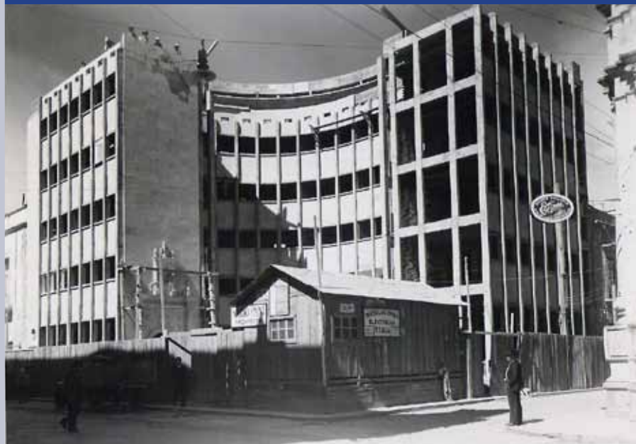
Figura 2. El Hotel Alameda (1937) durante su construcción
