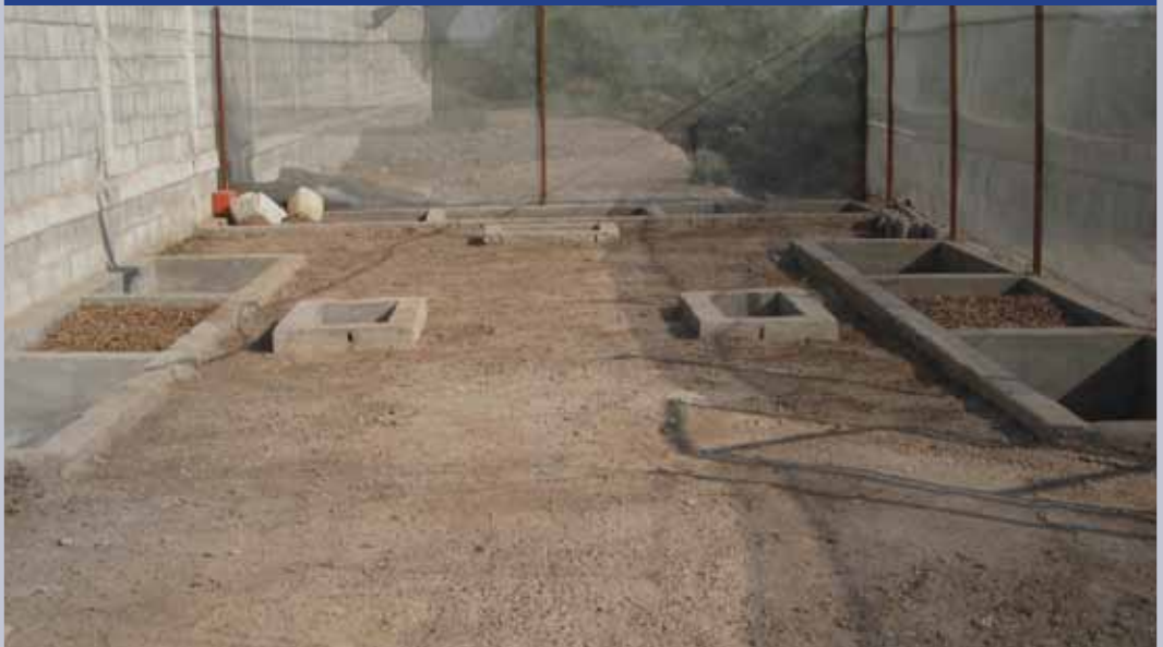
Ilustración 6. Complejo piloto experimental de vermicomposteo (fase de construcción)
