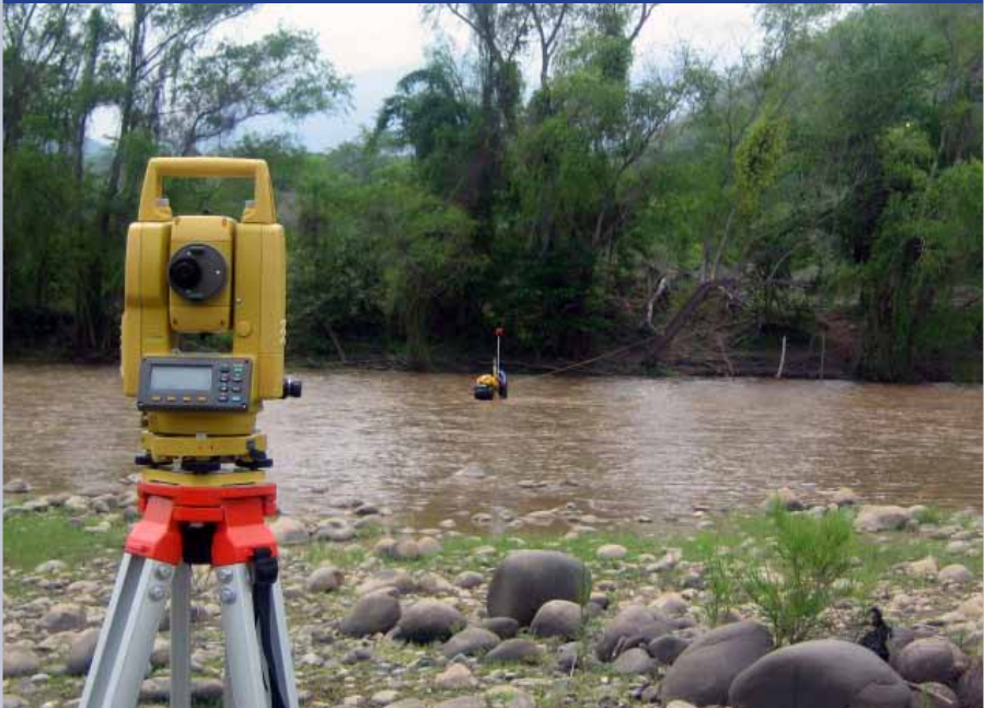
Figura 3. Levantamiento topográfico de la sección transversal del río Coahuayana como parte de los trabajos de campo
