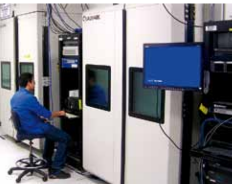
Área para pruebas y construcción de prototipos Centro de Ingeniería y Diseño Motorola.
