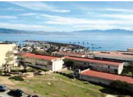
Vista del BIT Center Ensenada.
