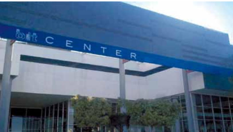
Otra vista de las instalaciones del BIT Center Tijuana.
