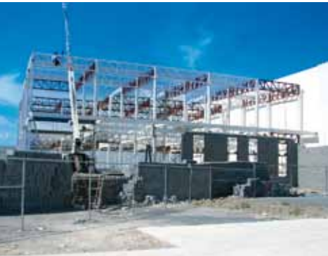
Construcción del Centro de Investigación en Materiales Avanzados, S. C. (CIMAV), Unidad Monterrey.
