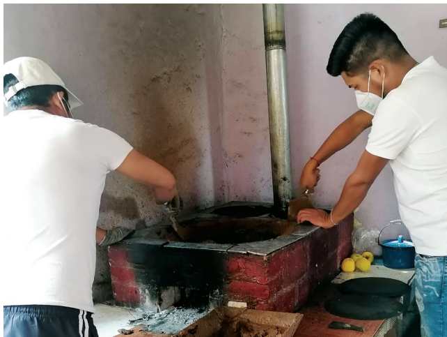
FIGURA 8. Acompañamiento en el largo plazo: reparación de estufas y reemplazo de piezas internas
