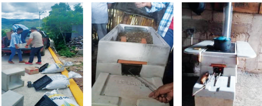
FIGURA 5. Estrategia de seguimiento para la construcción e instalación de una estufa de leña
