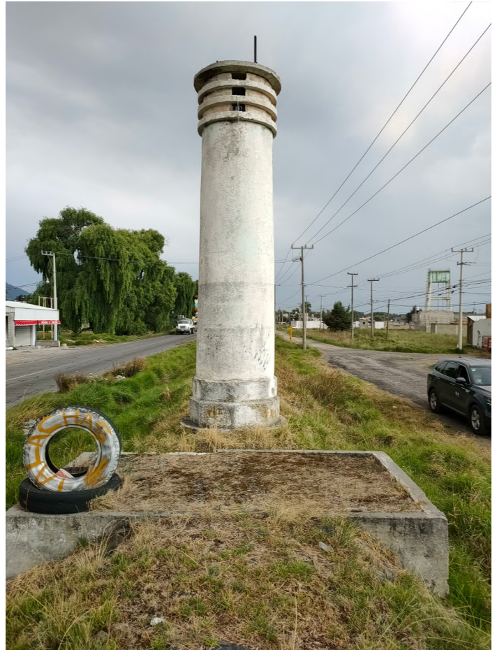
Figura 2. Acueducto y respiradero del Sistema Lerma. Fotografía de Edgar Talledos Sánchez.
